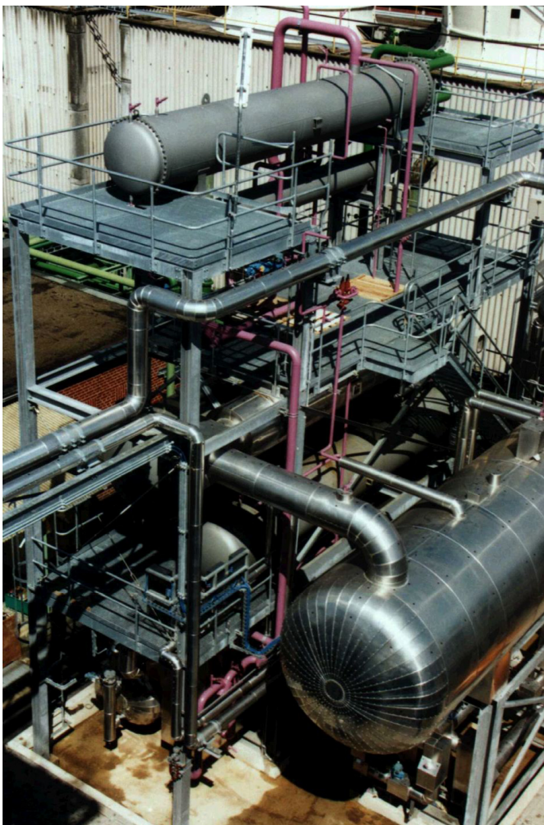
ARP-C-27 instalada en una refinería de petróleo en Alemania, 2700 kW a -30^{\circ}\text{C} .
